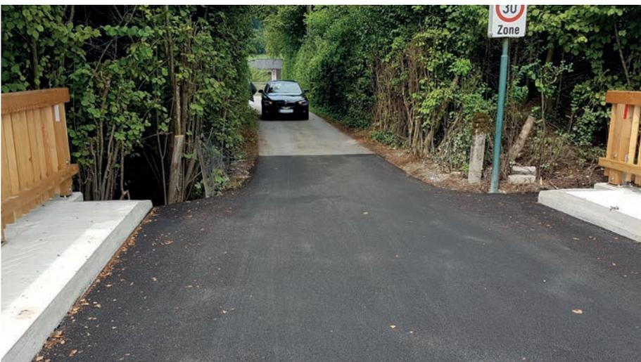
Aufgrund der in die Jahre gekommenen Bausubstanz des Geländers sowie der Brücke wurde eine Sanierung unumgänglich. Die Brücke wurde neu isoliert, ein neues Gelände errichtet und abschließend neu asphaltiert.
